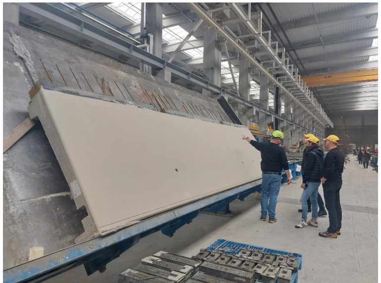
Rys. 6. Wielkoformatowe element prefabrykowane w wytwórni ForMee
