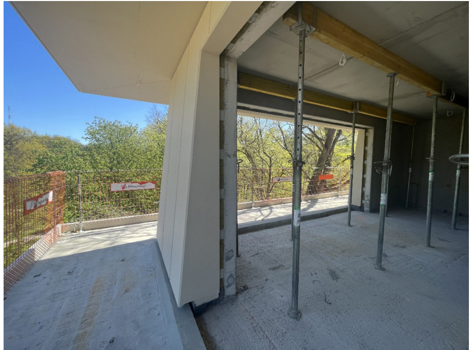
Rys. 11. Montaż wielowymiarowych elementów prefabrykowanych na budowie Greeneri Park w Świnoujściu
