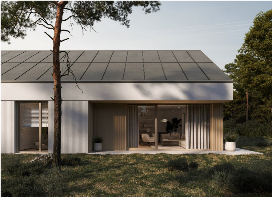
Rys. 13. Dom jednorodzinny wykonany w technologii prefabrykacji wielowarstwowej
