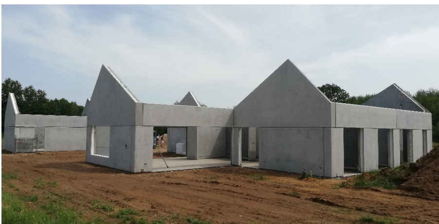
Rys. 14. Wznoszenie domu w technologii prefabrykacji wielowarstwowej [Dom w Grzecznicach]
