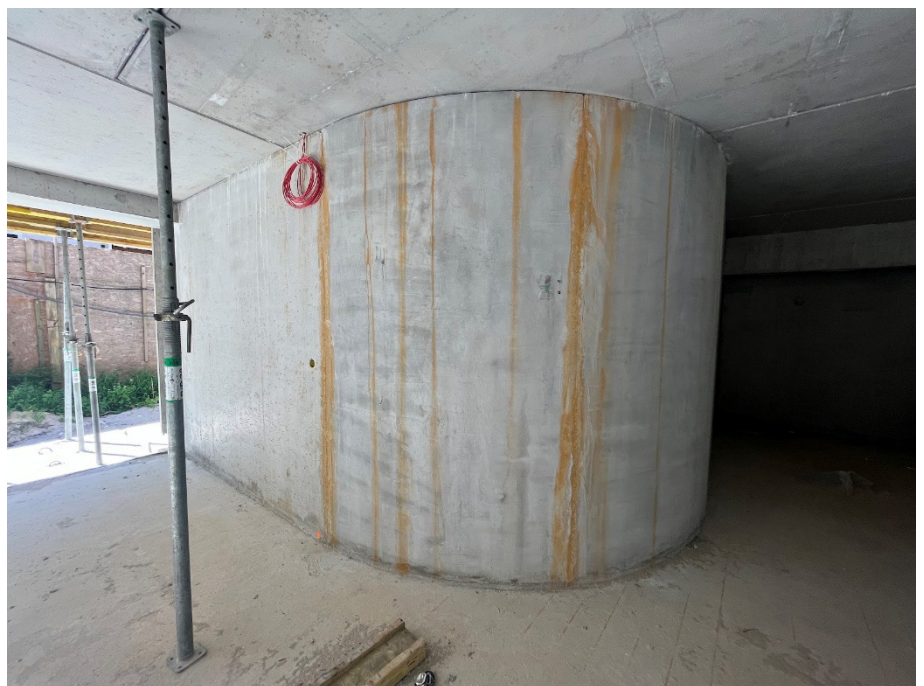
Rys. 12. Półokrągłe ściany hallu wejściowego w budynku Greeneri Park w Świnoujściu
