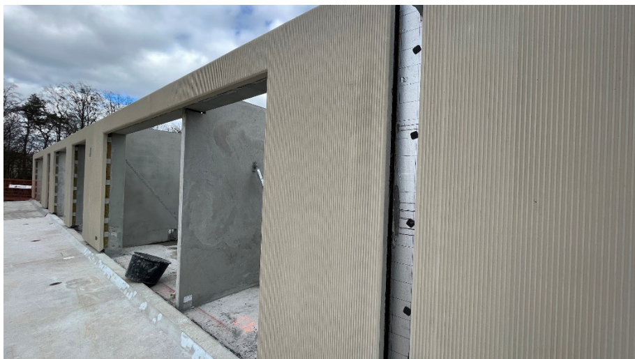
Rys. 10. Prace na budowie apartamentowca Greeneri Park w Świnoujściu
