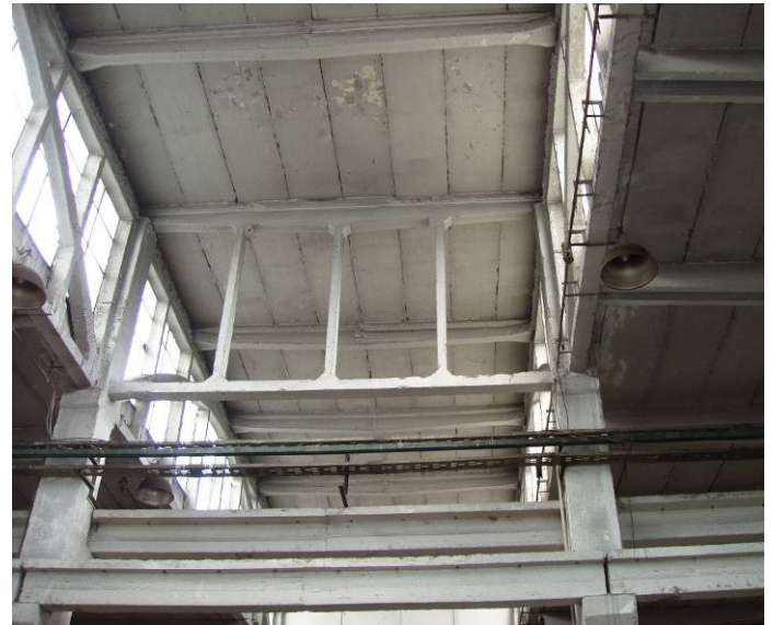
Rys. 2. Widok hali żelbetowej z pianobetonowymi płytami dachowymi
